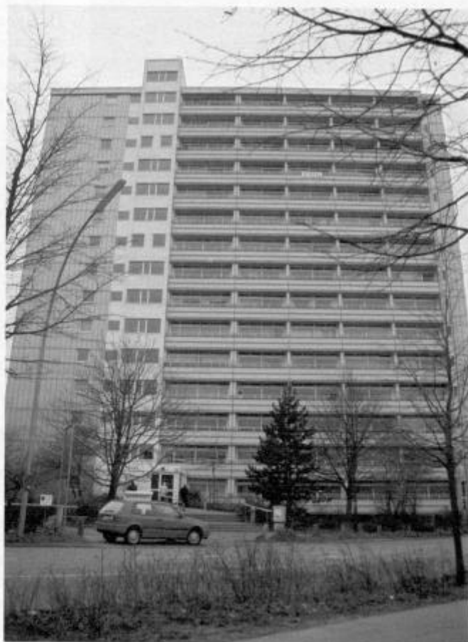
Allwo-Mietshaus mit 186 Eigentumswohnungen in der Julius-Brecht-Straße 11 in Hamburg/Groß-Flottbek. Den Vertrieb der Mitte der 60er Jahre gebauten Wohnungen hat die Heinen-&Biege-Gruppe übernommen.
